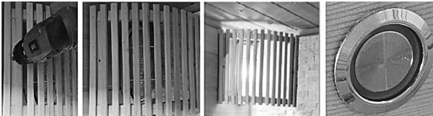
Holzabdeckung der explosionsicheren Lampe
